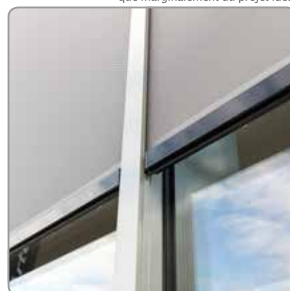
Renson s'est attelé au développement d'un profilé spécial pour une façade à montants et traverses de 60 mm de large
