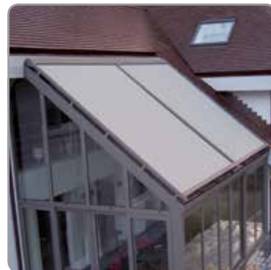
Gekoppelde montage op veranda
